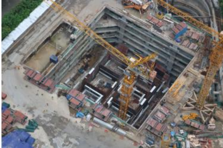
“逆作法”施工现场
